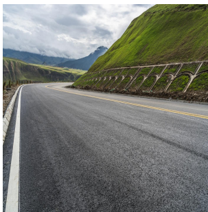
公路边坡监测
